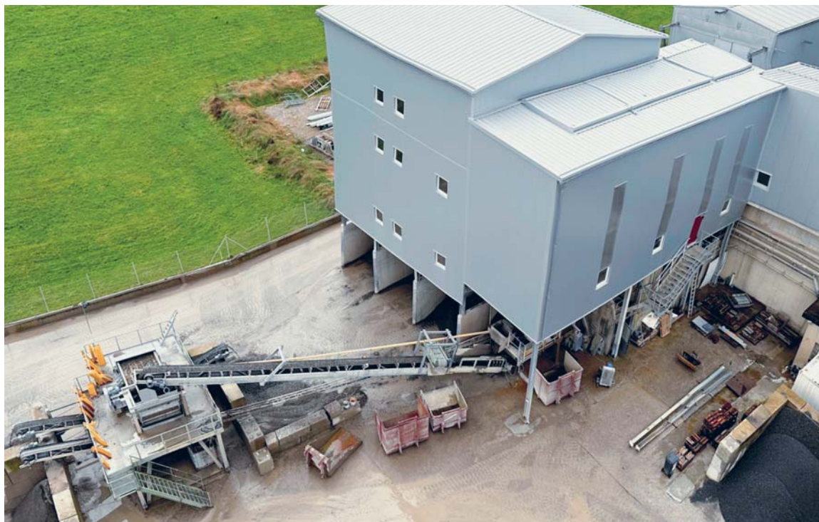
Feinstsandtrennung in neuer Einhausung.
