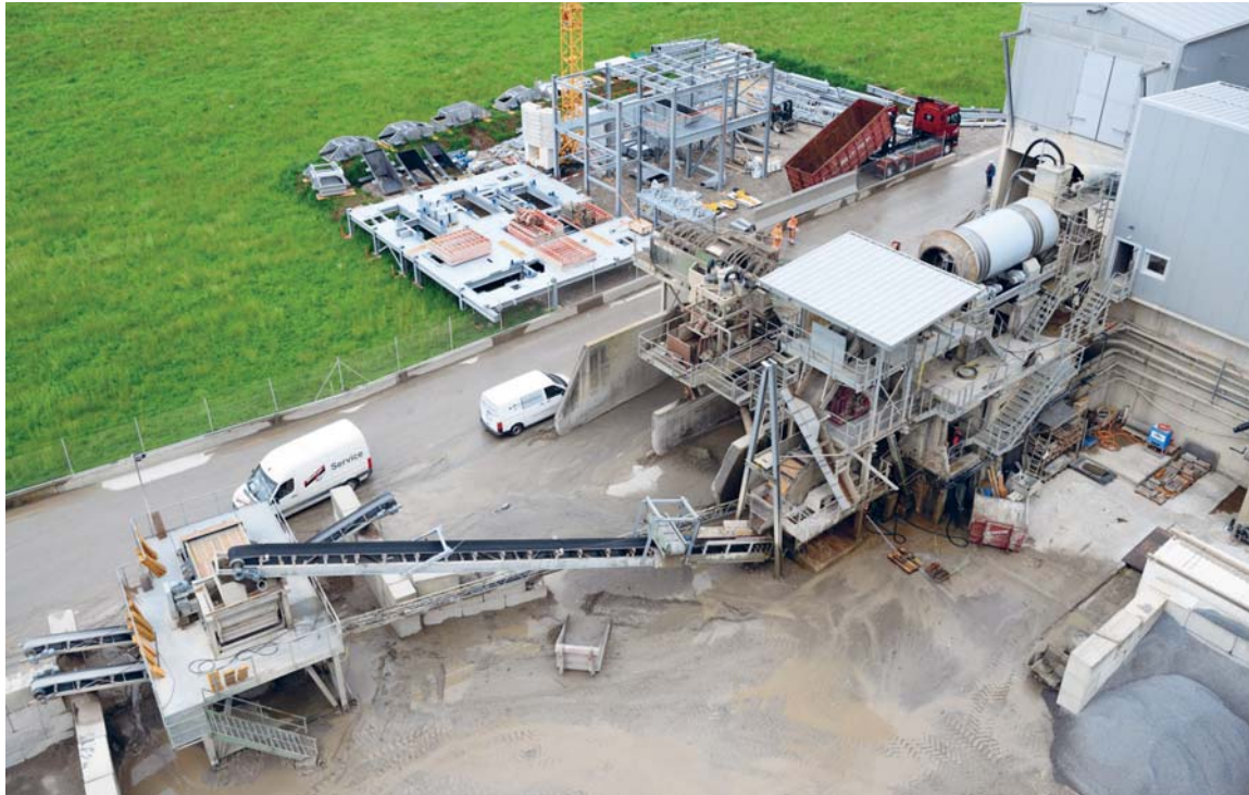
Alte Bodenwaschanlage ohne Feinstsandtrennung. (Die neuen Anlagen werden im Bild bereits vormontiert.)
