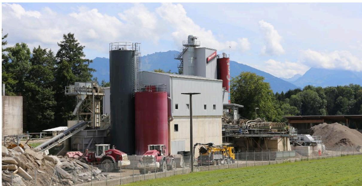
Im Werk Hinterwis der Blöchlinger AG in Neuhaus befinden sich eine Bodenwaschanlage und eine Schlammaufbereitungsanlage. Damit gewinnt das Unternehmen Recyclingkies und -sand. Diese werden für den Recycling-Markenbeton NeoCret eingesetzt. (Quelle: Blöchlinger AG)
